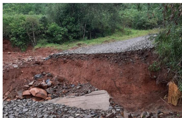
Foto 58 - Bloqueio de estrada devido à queda de barreira em Aratiba
