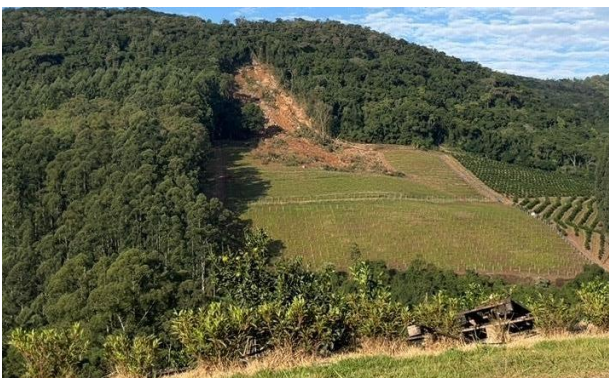
Foto 55 - Diversas áreas com deslizamento de terra em Caxias do Sul
