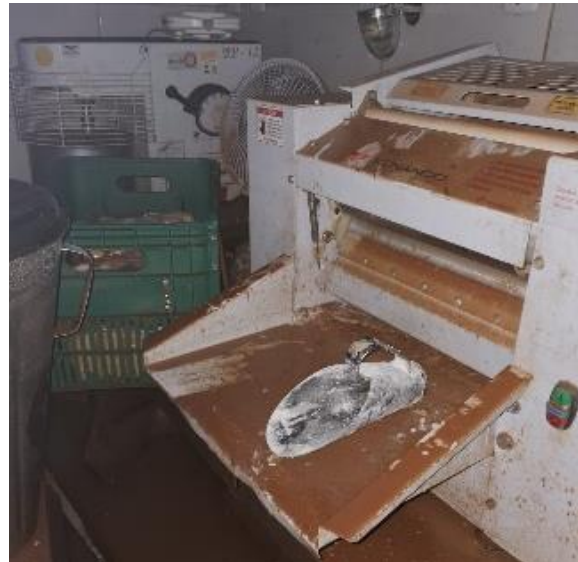
Foto 48 - Estrutura de agroindústria após enchentes em assentamento em Nova Santa Rita
