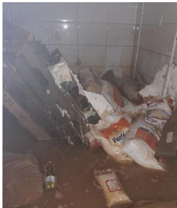
Foto 82 - Estrutura de agroindústria após enchentes em assentamento em Nova Santa Rita
