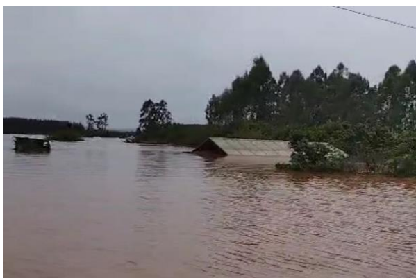
Foto 7 - Moradia inteiramente submersa em Taquari
