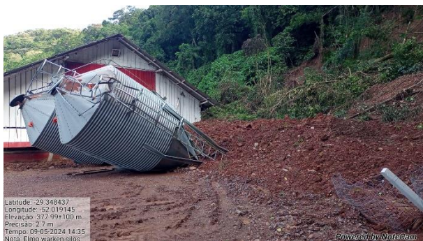
Foto 9 - Silo e aviário atingido por deslizamento em Arroio do Meio
