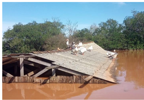
Foto 8 - Galpão submerso em assentamento em Nova Santa Rita
