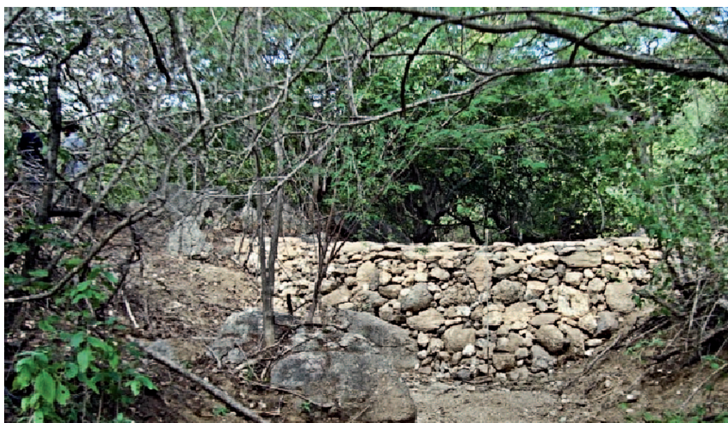
Figura 8 – Barragem Subterrânea com Sistema de Captação Ampliado
