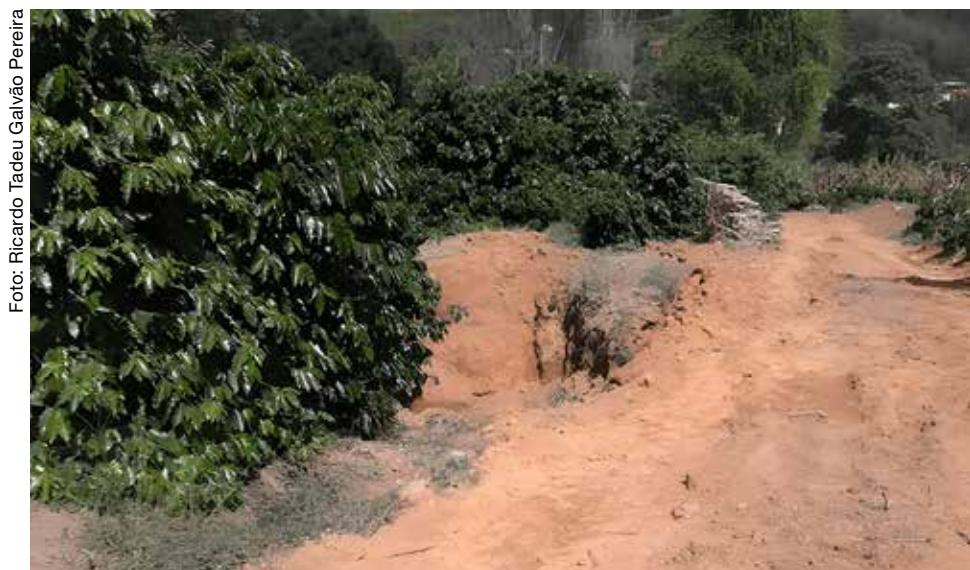
Figura 4. Bacias de captação de água de chuva com camalhão para direcionamento do fluxo de água da estrada. São João Batista do Glória, MG.
