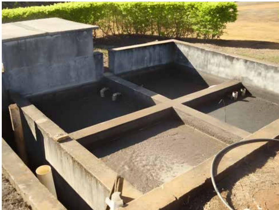
Figura 9. Tanque de estabilização de efluente de pós-colheita via úmida do café. Paula Cândido, MG.
