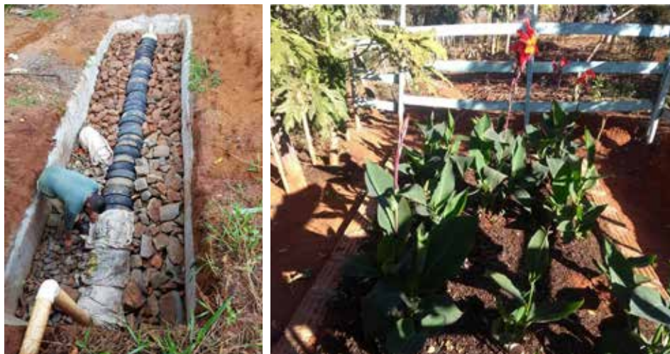
Figura 8. Fossa tipo tanque de evapotranspiração (Tevap) em construção (à esquerda) e finalizada (à direita). Fervedouro, MG.
